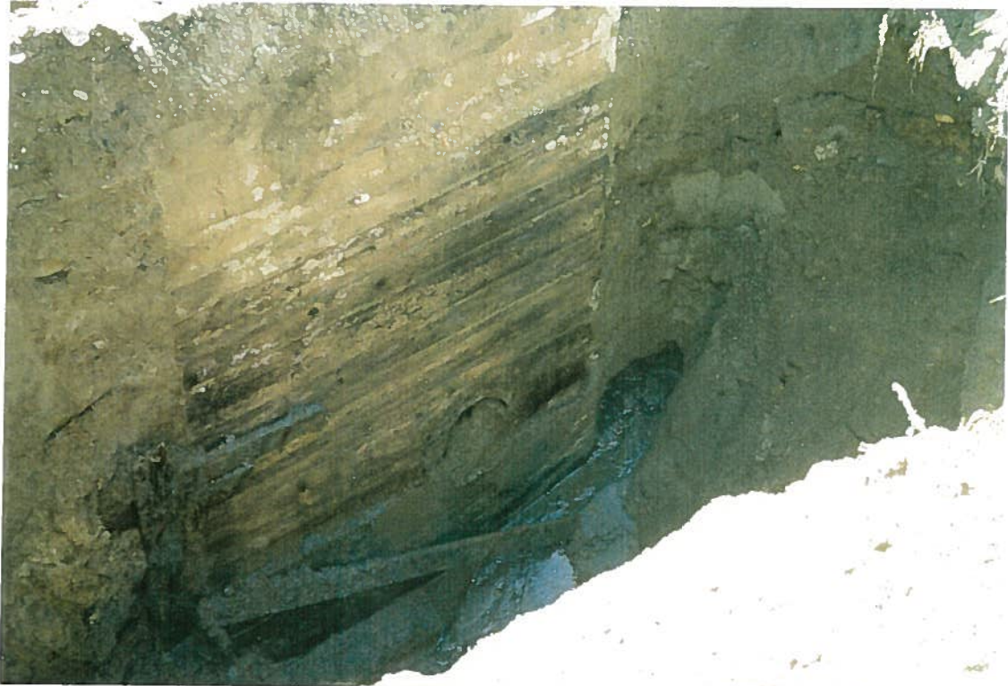
Oljeforrensning ved utløp for oljeutskiller
