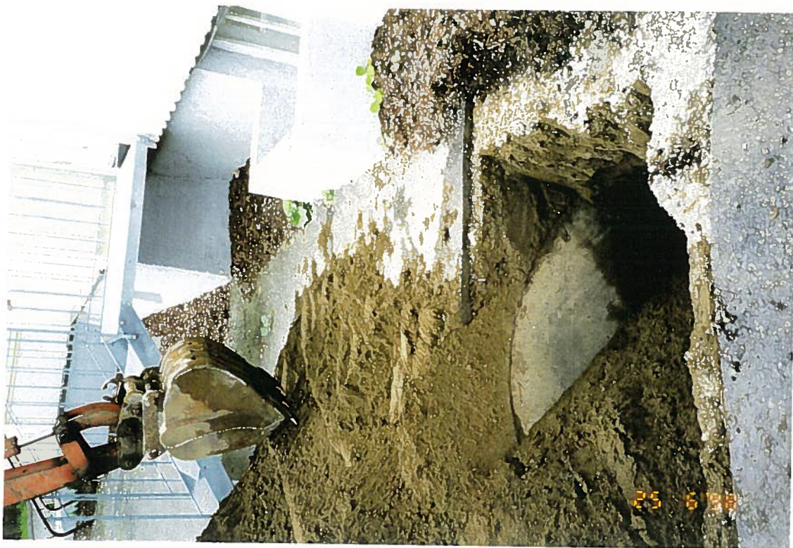
Sjaktig ved tank nr. 2. Det ble ikke påvist oljetørrensning her.
