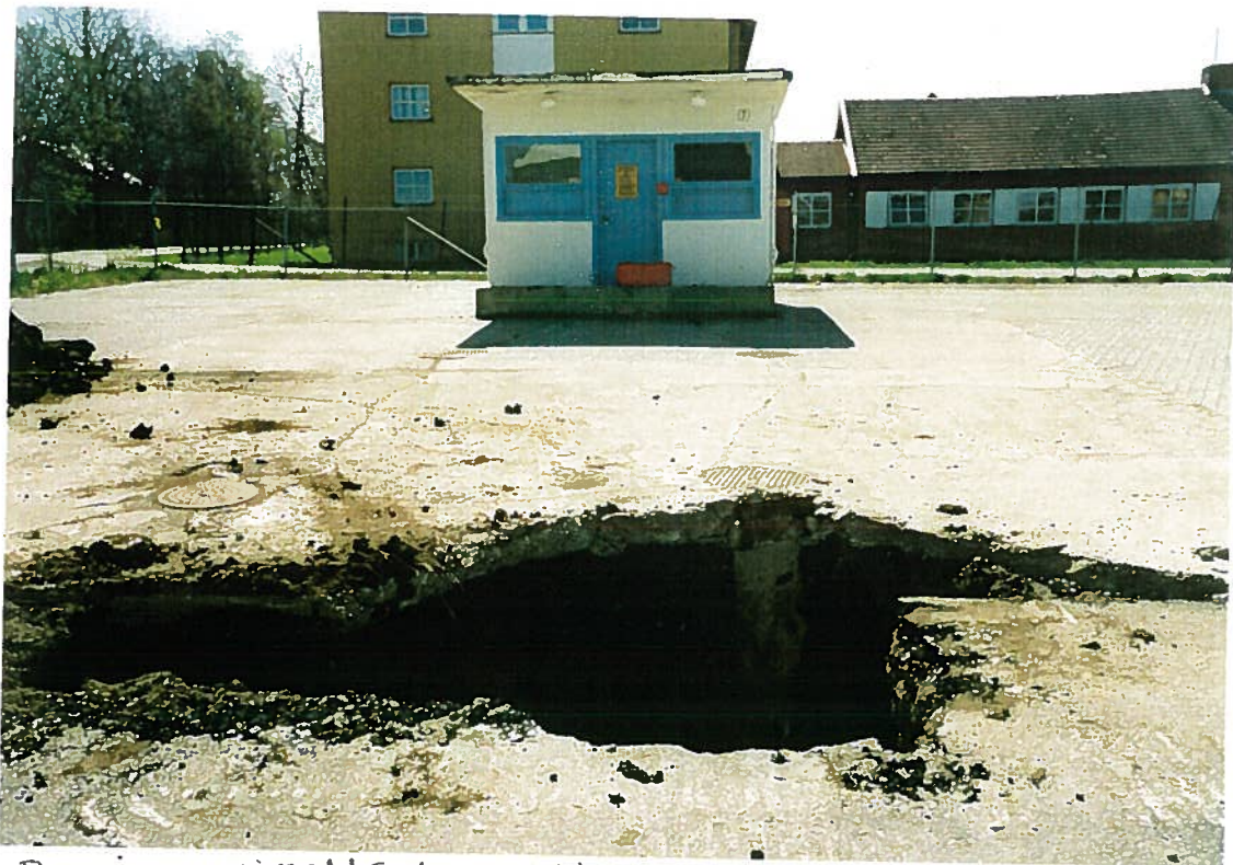
Bensin- og dieseltankene ligger under betongplata, mot pumpehuset. Begge vannledere søes.
